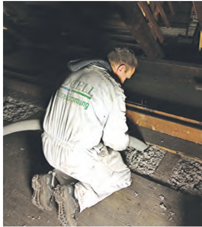
Utilajul transportă celuloza prin intermediul furtunului de transport in spațiile dorite.
