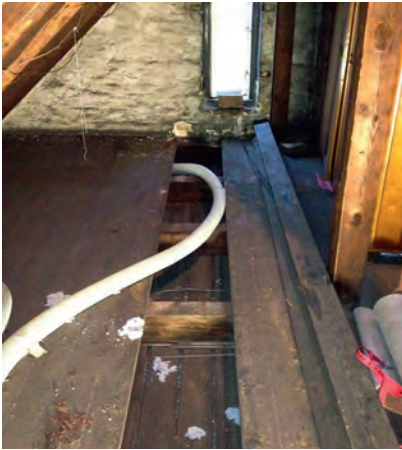
Se transporta doar furtunul de injectare și nu tone de material.
